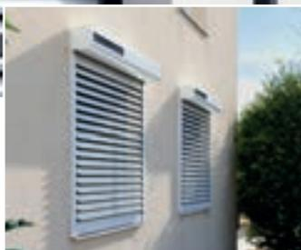
**FEM** Option isolation renforcée du tablier ( $\Delta R=0,25m^2.K/W$ )
